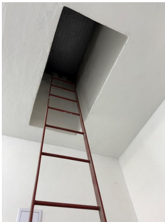
Foto č. 4: Výstup pomocí ocelového žebříku se kterým problematicky manipulovali dvě osoby; poklop se nepodařilo zvednout; nahradit stávající žebříky hliníkovým a provést ve výlezové šachtě úchyt na zavěšení – stabilizaci žebříku a provést zajištění bezproblémového otevírání poklopu
