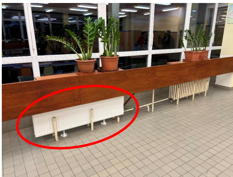
Foto č. 5: Výměna jednoho litinového radiátoru, za deskový; v některých třídách schází termohlavice na radiátorech
