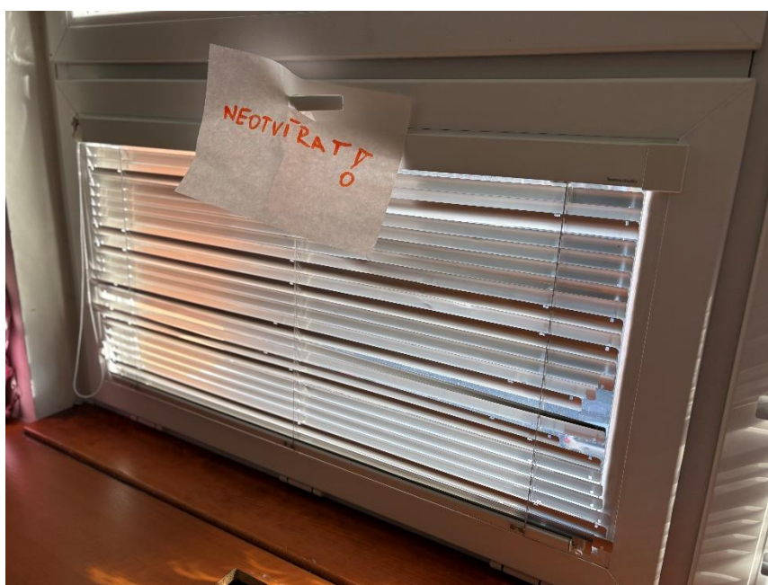
Foto č. 9: Poškozené vnitřní žaluzie
