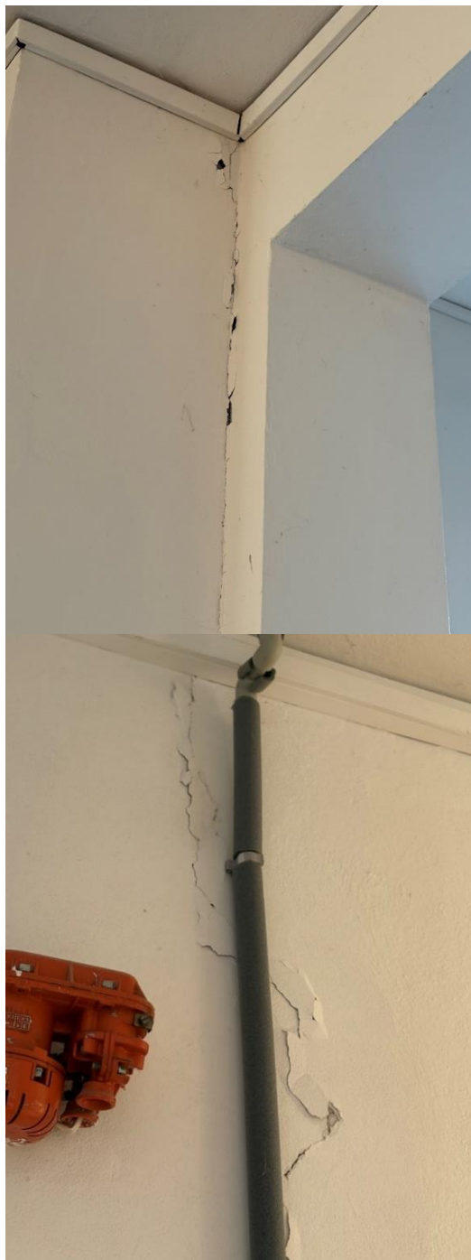
Foto č. 11: chodba před tělocvičnami; horní foto: pravděpodobně dilatační pohyb opláštění versus nosná konstrukce; provést proškrábnutí spáry, tj. vytvořit spáru a tu vyplnit pružným (bílým) tmelem; dolní foto: opět podle všeho vliv objemových změn (uvolněná omítka od podkladu); doporučení osekát omítku a vyhodnotit stav nosné konstrukce
