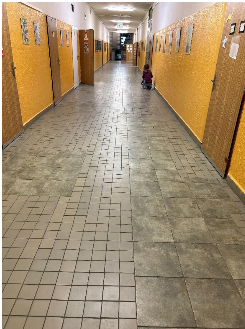
Foto č. 3: Výměny dlažeb; jde jen o estetiku; aplikovat vždy dlažbu, která splňuje podmínky kluzkosti
