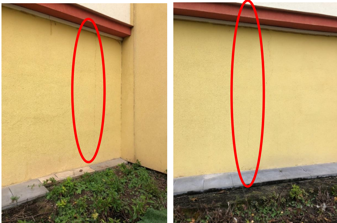
Foto č. 1 a 2: Trhliny v omítce; doporučení: osadit pásy ev. měřidla, jak a jestli dochází k pohybům
