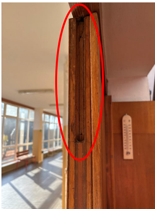
Foto č. 8: Vypadlá závlač dveří v tělocvičně
